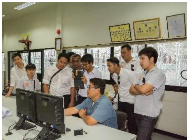
รูปที่ 5 ระบบควบคุมและสั่งการในสถานี
