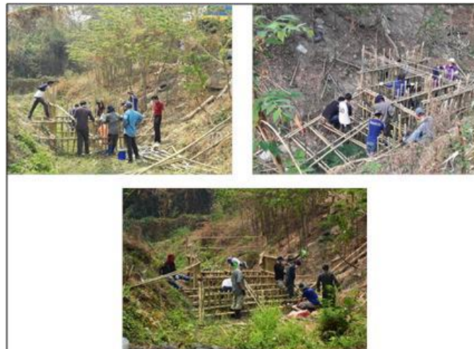
รูปที่ 4 การวางโครงสร้างหลักของฝายมีชีวิต
