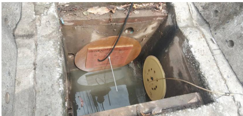
รูปที่ 12 การติดตั้งประตูกั้นน้ำสำหรับการควบคุมน้ำเขตเทศบาลแม่จัน
