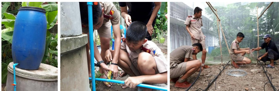
ภาพที่ 4 การติดตั้งระบบน้ำหยด
